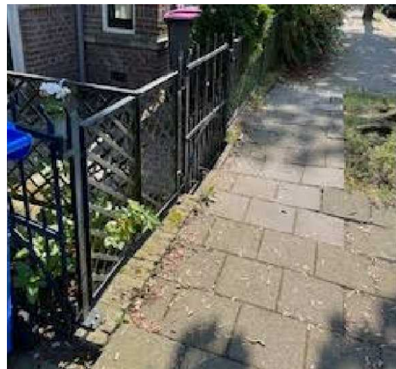
IJzeren hek met diagonale strips op sierband (nr 11).
