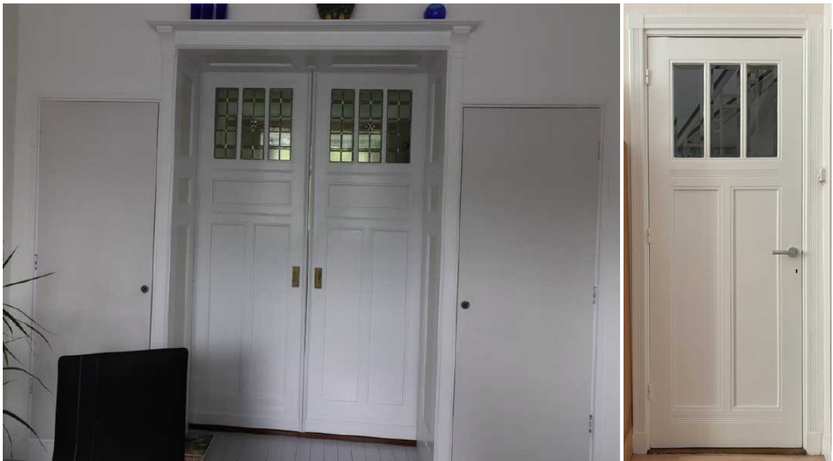
Suitedeuren met glas in lood (nr 3), binnendeur (nr 17), omlijstingen.
