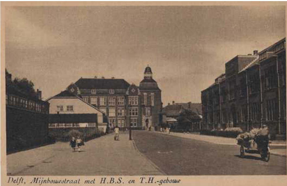
Foto na de oorlog? Tussen de loods van het TNO- Vezelinstituut en de garages heeft een kleiner gebouwtje gestaan, zie ook p47. Deze is later vervangen door een loods, zie p14.
