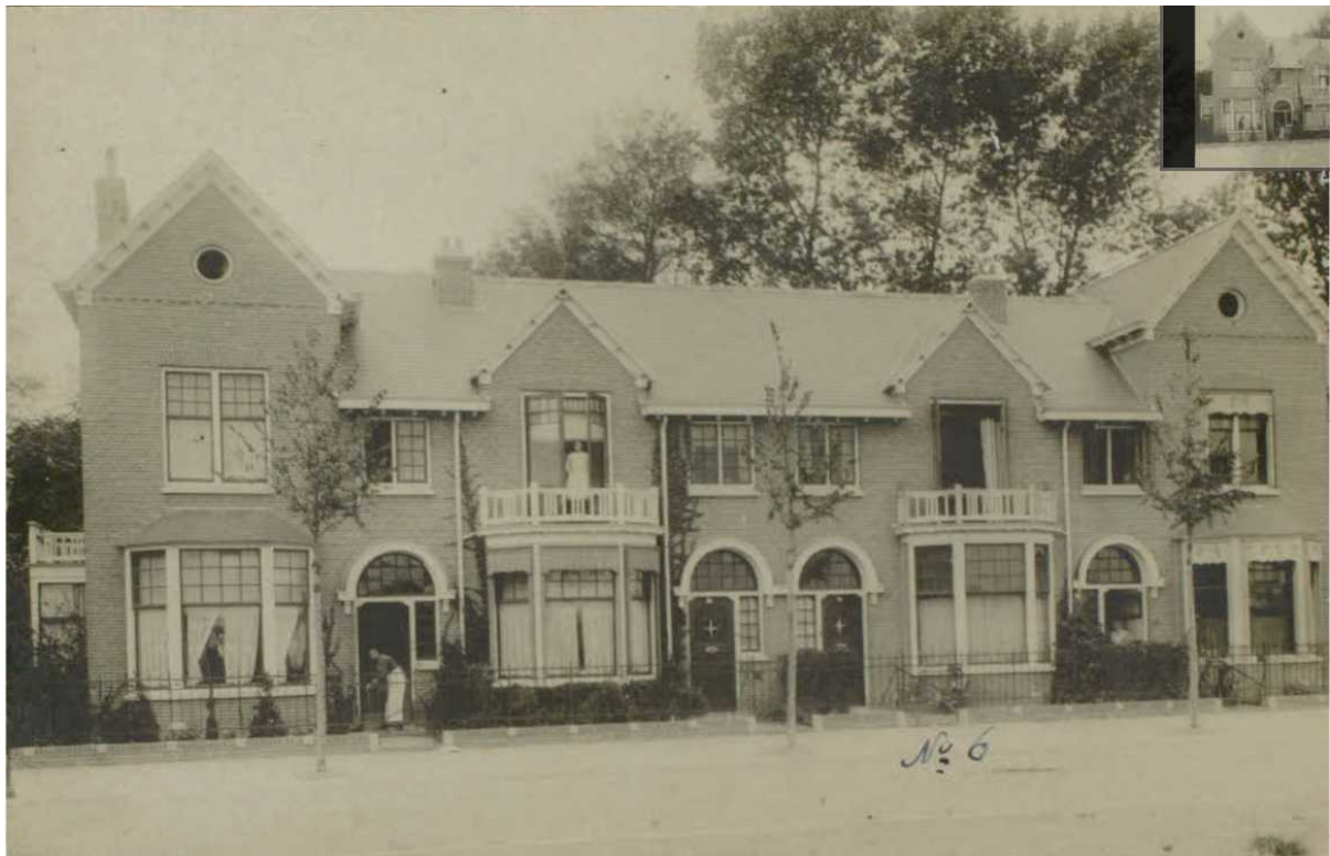
30.12.1914 (nrs 2-8). Bij nr 4 is aan weerszijden van de erker het begin van klimop te zien. Achter de woningen de bomen in de tuin van de Verffabriek, zie hfdst 4.2.
