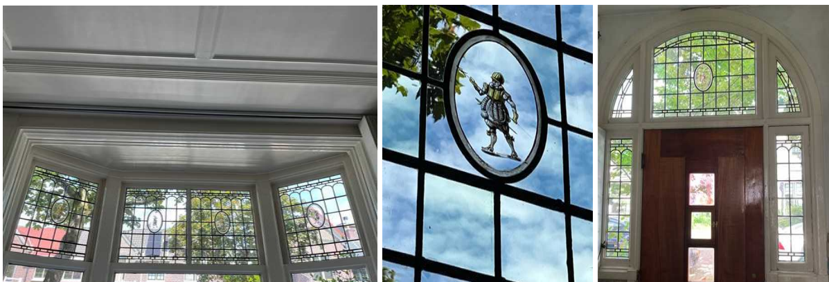
Erker met glas in lood, betimmeringen en plafondstucwerk (nr 7). Volgens de firma Zantman, nog tot voor kort actief, hebben zij indertijd het glas in lood geleverd. Hiervoor waren catalogi met vaste patronen waaruit gekozen kon worden waardoor het per woning kan verschillen. Het glas in lood zit alleen aan de oneven zijde, aan de even zijde zat in de bovenlichten lichtgroen glas.
