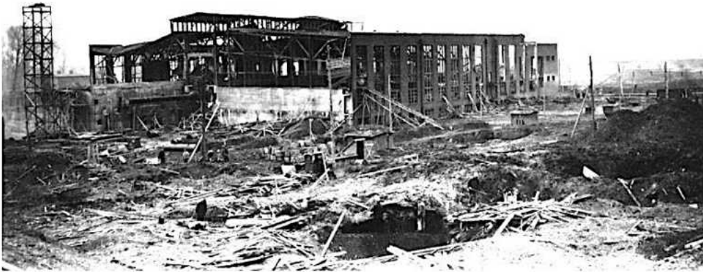
ZERSTÖRTES WASSERWERK DER BUNA-WERKE 1945
